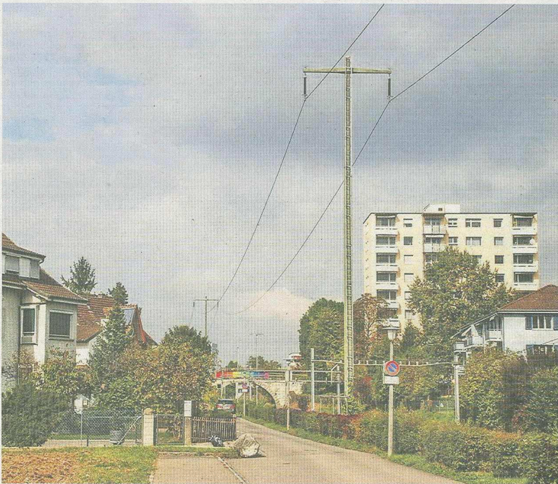
Zankapfel: Der Mast an der Dammsstrasse auf der Höhe der Gartenstrasse.
